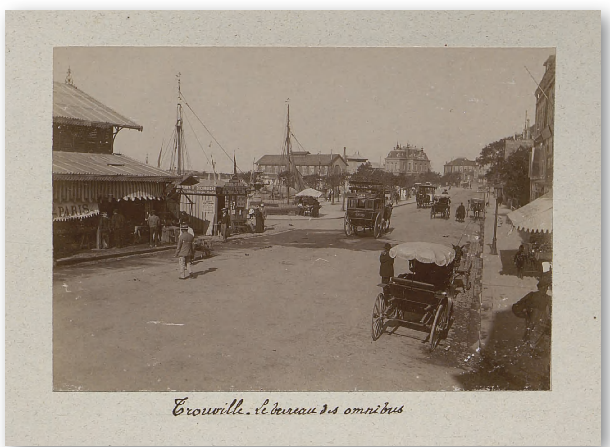
Trouville en 1893, avant le nouveau casino construit place Foch en 1912. La mairie, le haut bâtiment à droite du marché couvert, fut détruite en 1913 et reconstruite un peu plus loin. Tirage photographique collé dans un album. AD14, 2Fi/793.
