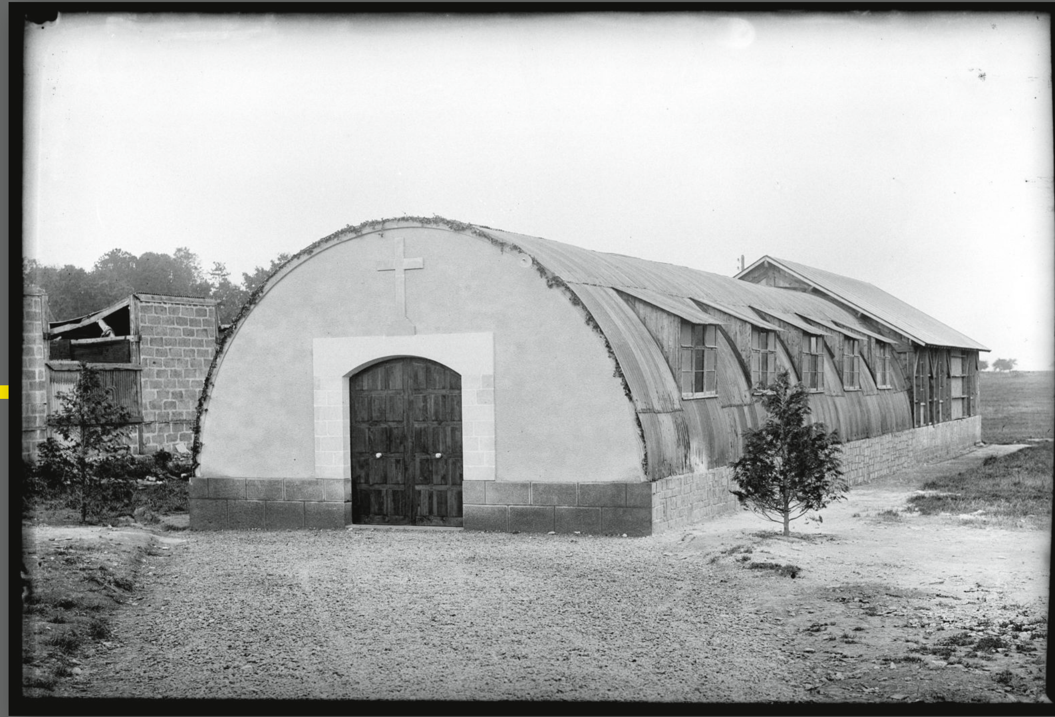
Chapelle provisoire de type « tonneau » érigée durant la Reconstruction dans le quartier de la Maladrerie à Caen, vers 1947-1950, par Robert Delassalle. Restitution numérique positive d'un négatif sur plaque de verre. AD14, 130F/1.
