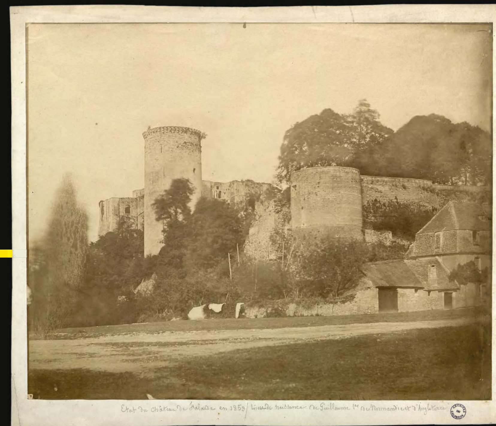
Château de Falaise, vers 1851, par le photographe Hippolyte Bayard. Tirage sur papier salé. AD14, 2F1/418 (n° 7).
