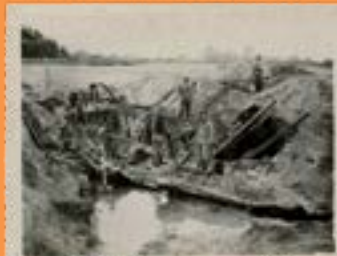
Aménagement des canalisations d'égouts à Houlgate. Avril 1949 1542W 543/3 - Fonds des dommages de guerre du Calvados
