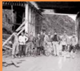
Les ouvriers de Condé-sur-Noireau prennent la pose devant le pont qu'ils reconstruisent. Vers 1950 82Fi 450 - © Archives du Calvados, Robert Desauany
