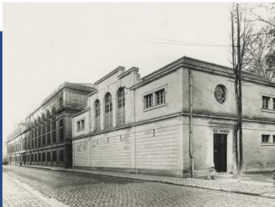
Le bâtiment des Archives du Calvados rue Saint-Laurent avant 1963. AD14, 644W/105
