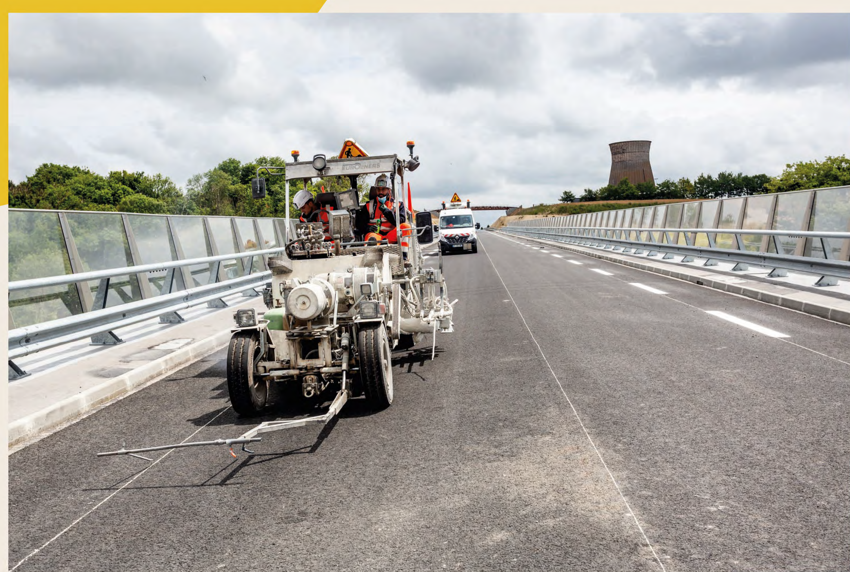
Les travaux de la desserte portuaire par le Département du Calvados. © Cliché : E. Fossey, 2021
