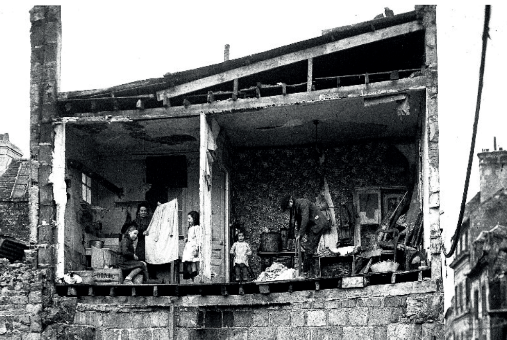
Maison détruite au 12 rue Basse Archives municipales de Caen - Fonds Legrand. 11_Z_5
