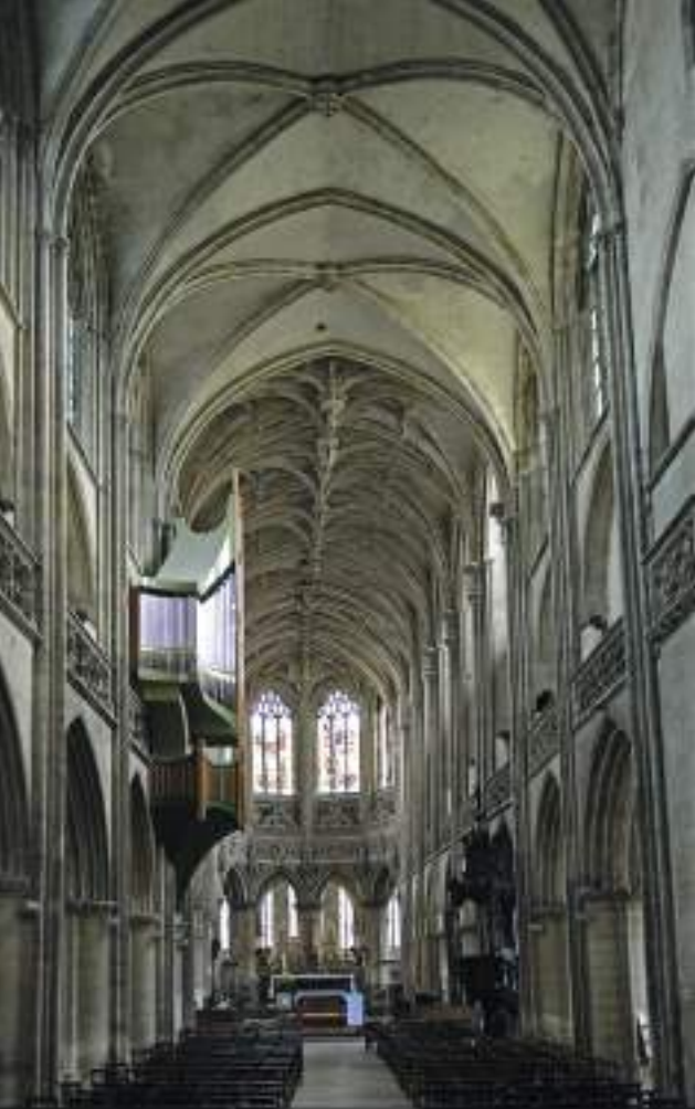
Vue intérieur de l'église Saint-Pierre François Decaens - Ville de Caen
