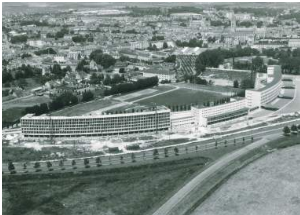
Vue aérienne du lycée Malherbe en construction, 1960 Archives municipales de Caen. 10FI_126
