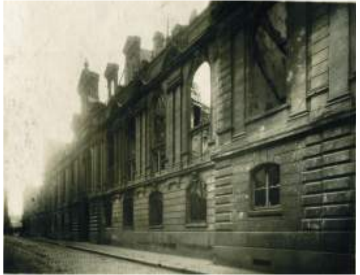
Façade de l'Université rue Saint-Sauveur après 1944 Archives du Calvados. 927W_35
