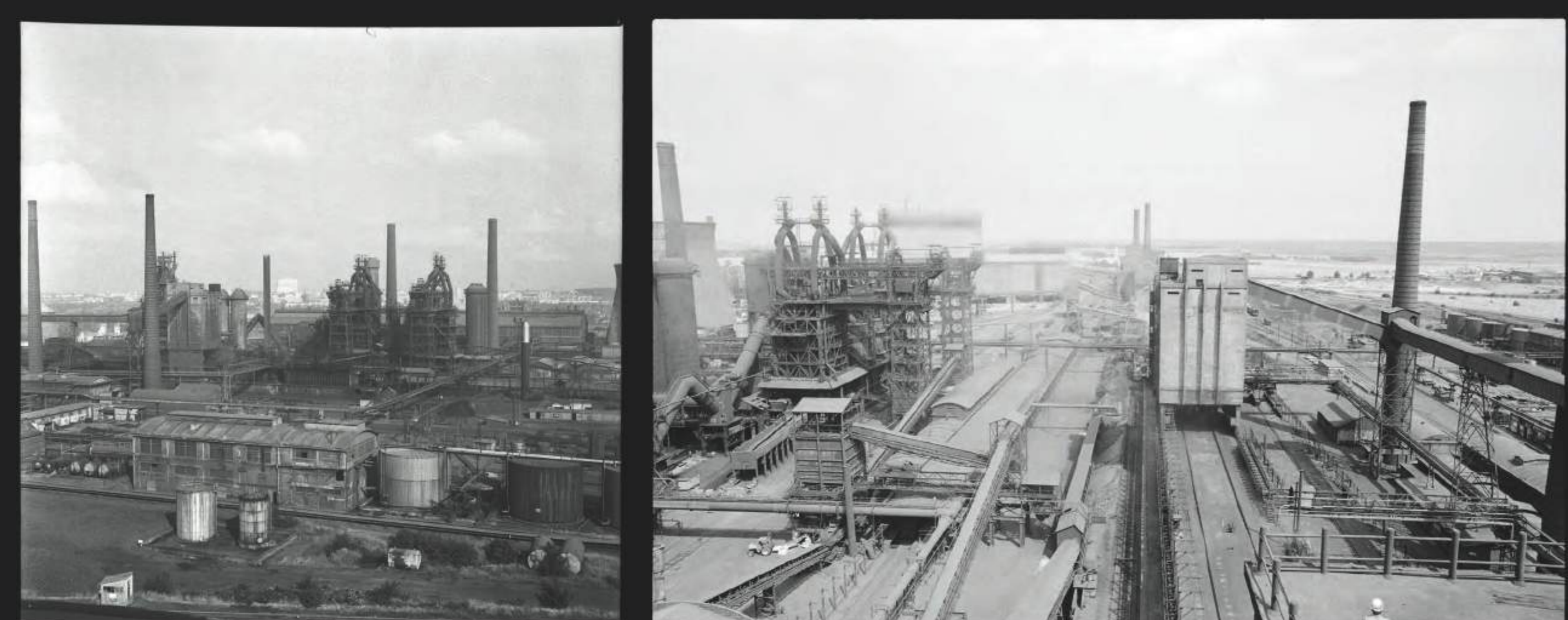
Société Métallurgique de Normandie, hautes-fourneaux 1, 2 et 3, août 1988
