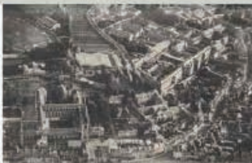
Photographie aérienne de l'îlot sanitaire à Caen
