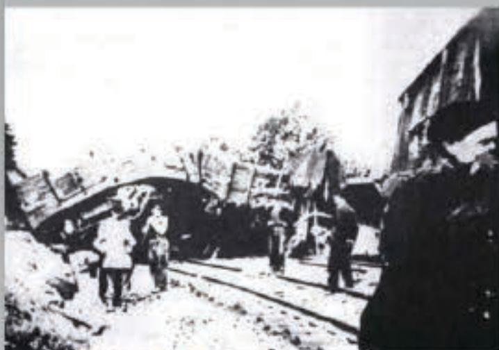
Sabotage d'un train de ciment Le 16 février 1944 à Saint-Aubin-des-Bois (Calvados). (Le Calvados après la libération de Marcel Luchet, la Résistance dans le Bocage, Basse-Normandie, Juin 1944 - Juin 1944, 134 p., Editions Granché, 2008, Mayet)
