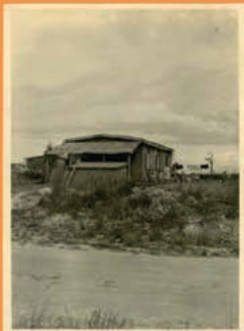
Baraquement provisoire construit en bois et carton bitumé, Calvados, 1945 Photo: Agf © Bibliothèque municipale de Caen
