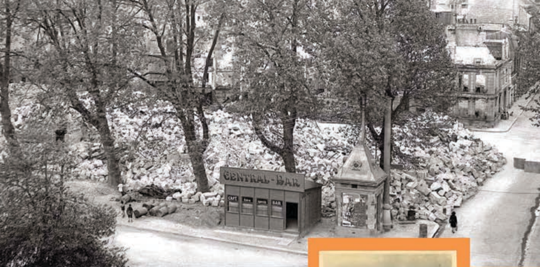
Baraquement provisoire construit en bois et carton bitumé, Calvados, 1945 Photo: Agf © Bibliothèque municipale de Caen
