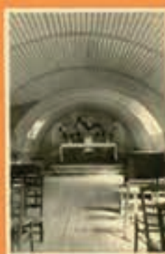
Baraquement provisoire construit en bois et carton bitumé, Calvados, 1945 Photo: Agf © Bibliothèque municipale de Caen
