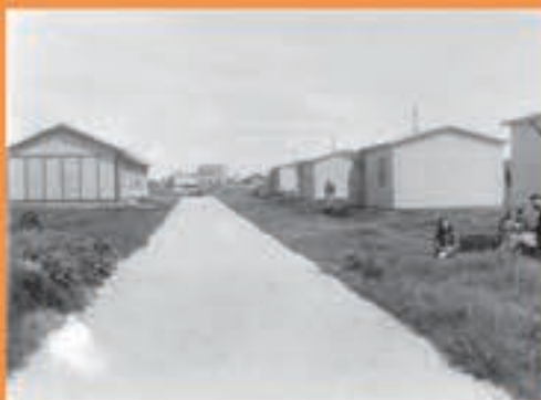
Un baraquement en Reconstruction provisoire attribué au Ministère de la Reconstruction et du Logement (1947-1963).
