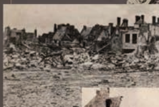
Falaise Les débris de l'église, 1944 © M. H. H. / Archives de Caen, Normandie
