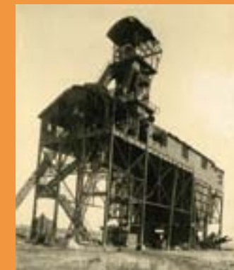
Un four industriel endommagé par les bombardements. Années 1945-1950 88Fi 90 - © Archives du Calvados, Amiot
