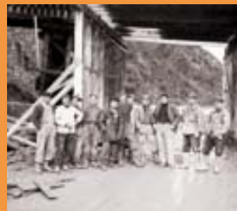
Les ouvriers de Condé-sur-Noireau prennent la pose devant le pont qu'ils reconstruisent. Vers 1950 82Fi 450 - © Archives du Calvados, Robert Desaunay
