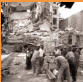
La démolition de L'Ancienne Mutuelle à Caen. 18 juillet 1946 5Num 192614 - © Archives du Calvados, Archives Houdan
