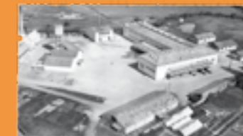
La laiterie Dupont d'Isigny reconstruite. Après 1949 1557W 4 - Fonds des dommages de guerre du Calvados
