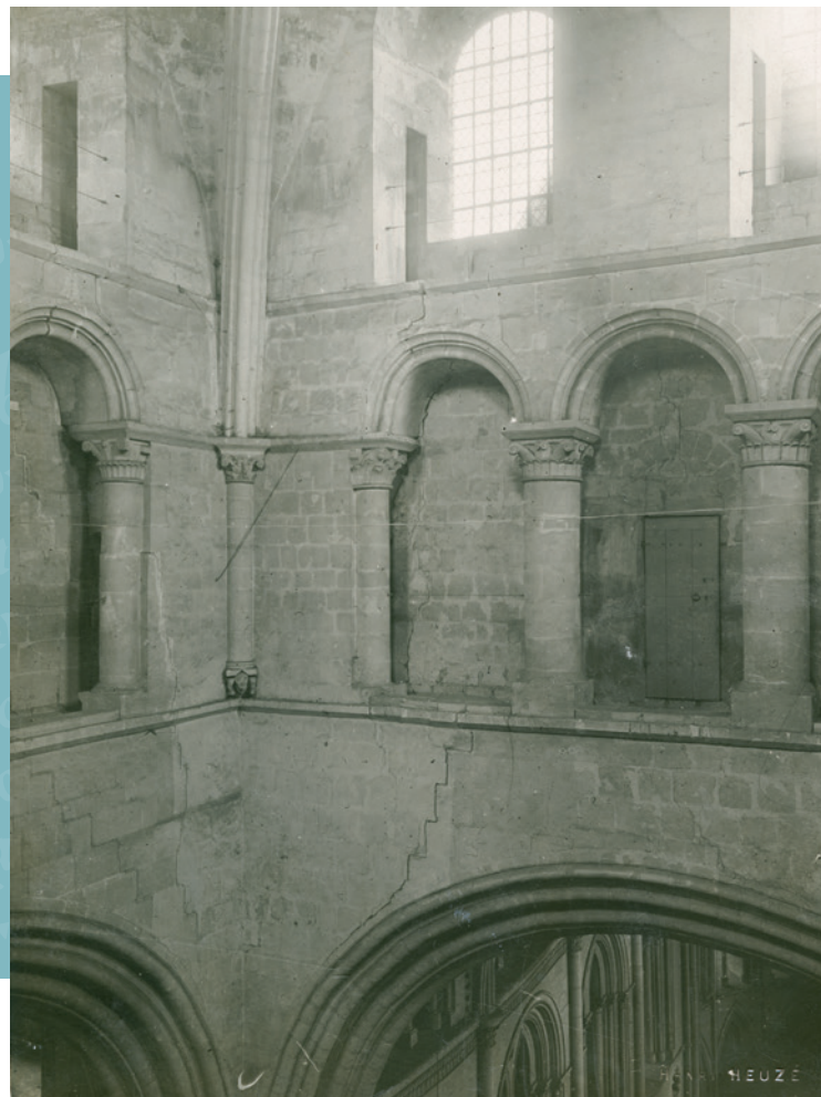
Partie haute de la tour de la lanterne de l'Abbaye-aux-Hommes, fin XIX e -début XX e , photographie d'Henri Heuzé, 0084/014/1012, Médiathèque de l'architecture et du patrimoine
