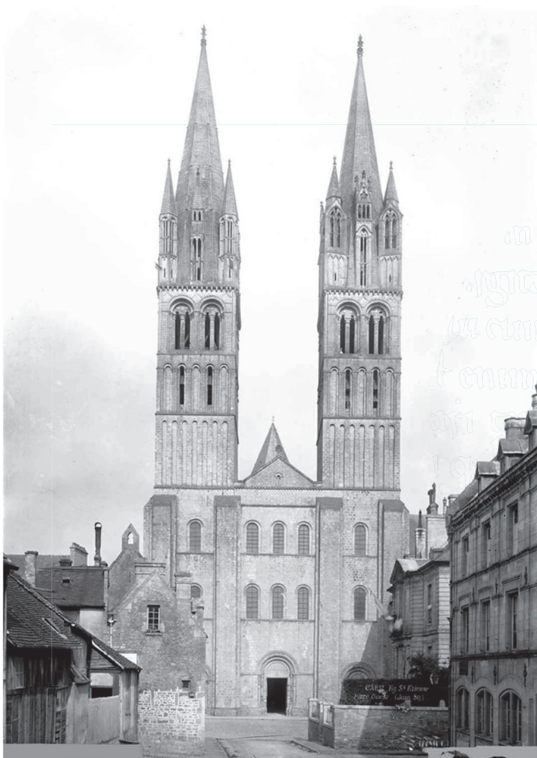
Façade ouest de l'église abbatiale Saint-Étienne, juin 1889, photographie de Jean-Eugène Durand, MH21858, Médiathèque de l'architecture et du patrimoine
