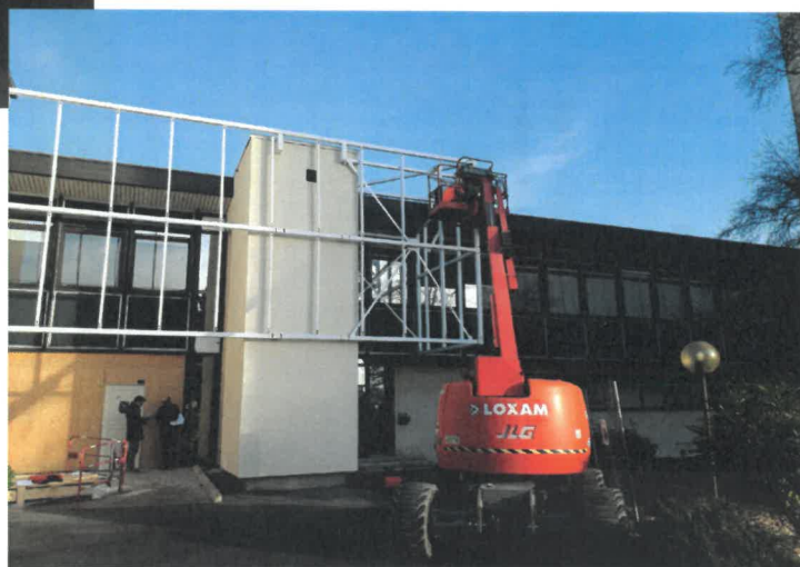
Pose du treillis de signalétique en façade
