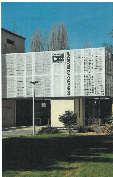
Le bâtiment après travaux.
