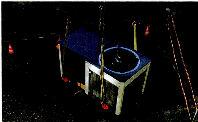
Groupe froid de la centrale de traitement de l'air
