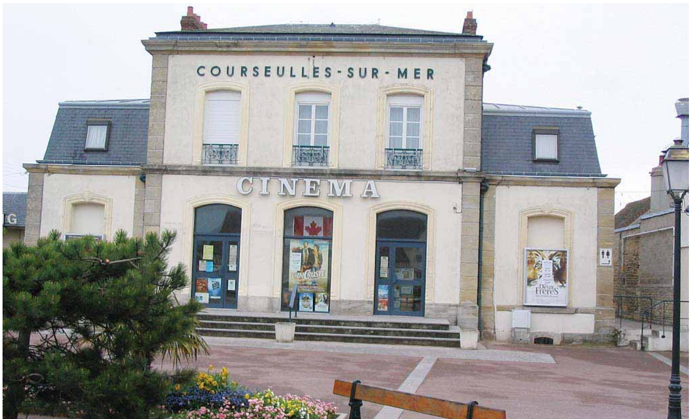
L'ancienne gare transformée, de nos jours, en cinéma. (Photographie Mme Divaret).
