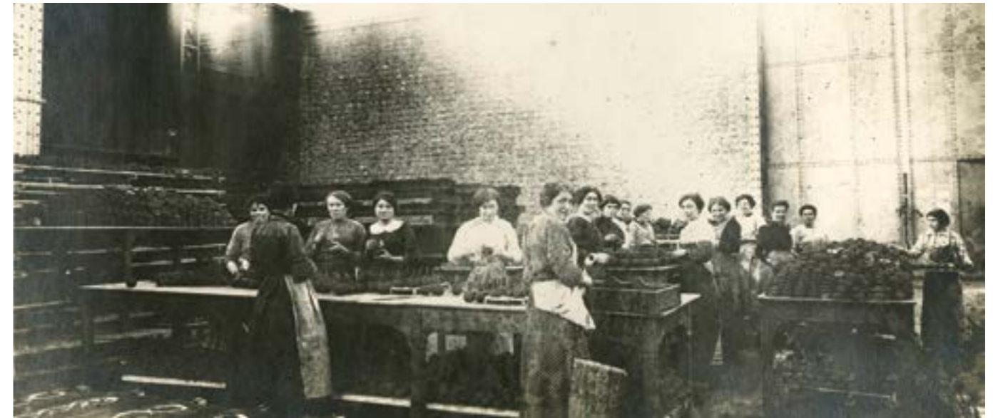
Les munitionnettes de la Société normande de métallurgie, non daté [entre 1917 et 1918] 2f/446
